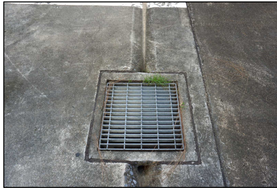
ภาพที่ 2-7 ตะแกรงดักขยะรางระบายน้ำ
